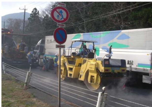
写真-8.2 水平振動ローラによる転圧状況
